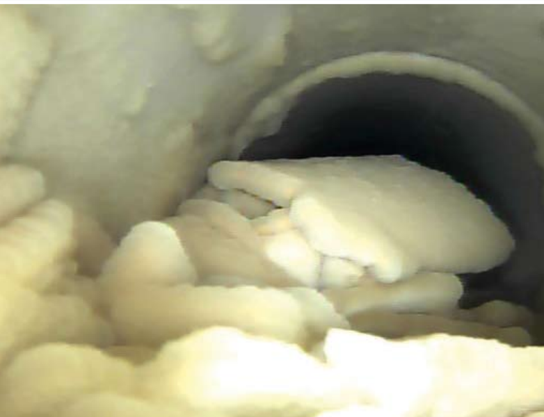
Trabalho em Catanduva (SP): Imagem da câmera mostra com clareza nível de incrustação.
