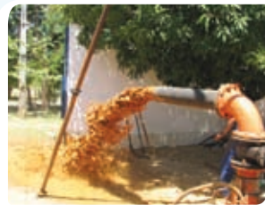
Desincrustação Química, recuperação de vazão e redução de ferro na água de poços
