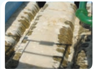
Regeneração de leitos filtrantes
