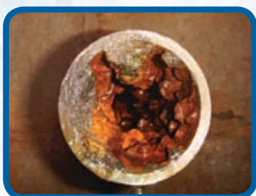
Ferro Incrustações relacionadas ao excesso de ferro.
