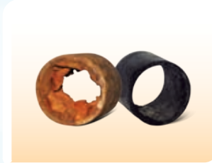
Desincrustação de redes e controle de metais
