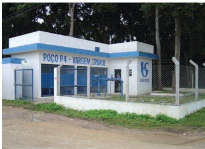
Urbanização P4 Vargem Grande - São Paulo/Sabesp
