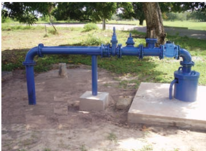
Cavelete de poço, com hidrômetro, válvula de retenção e laje de proteção.
