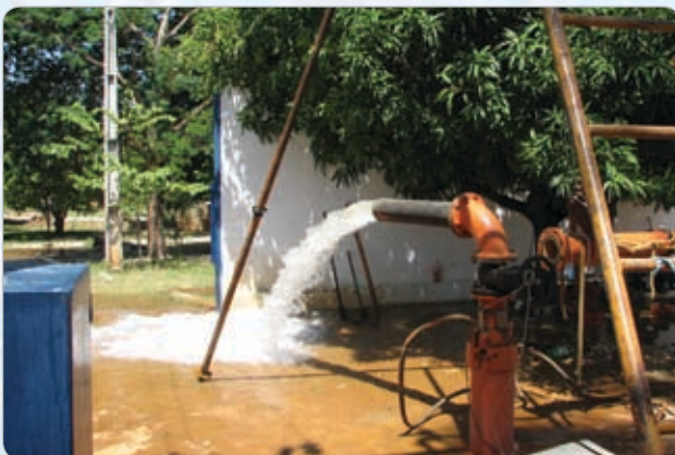
Após aplicação do No-Rust
