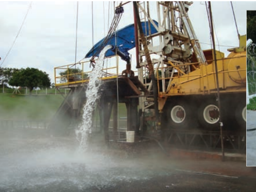
Fernandópolis, SP, P15 Sabesp com 1.460m de profundidade, T 54°C.
