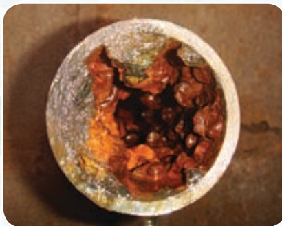
Incrustações internas nos dutos: um dos problemas que surge na rede hidráulica sem o uso do Econox.
